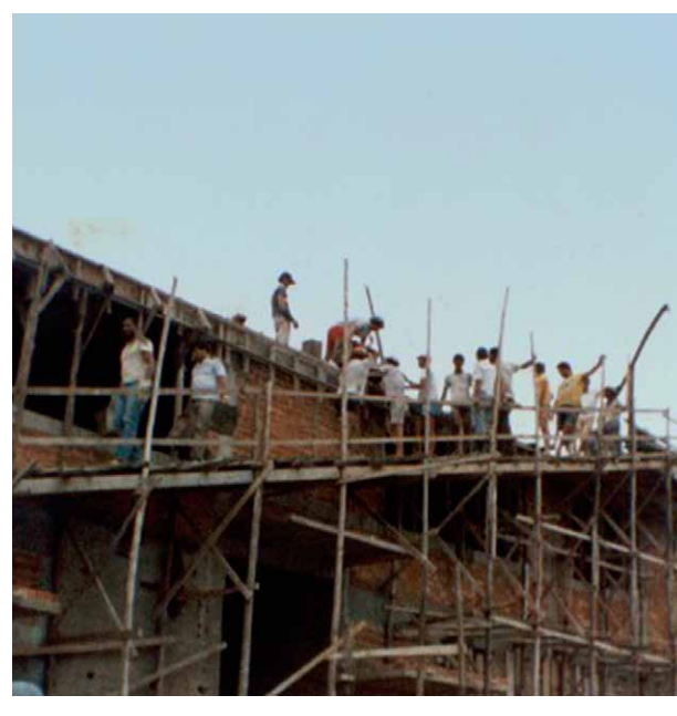
Construção do salão
